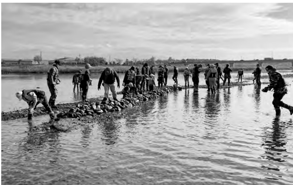
パーブエ（高さの低い水制の一種で、流れによって運ばれてくる砂を溜めて寄り洲を形成することを目的とした河川工法）
